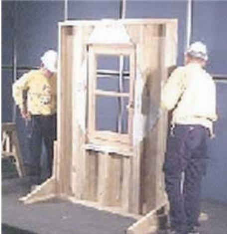
**Figura 14 - 34:** Colocación de la barrera de humedad en el rasgo de ventana desde el paramento exterior hacia el interior.
