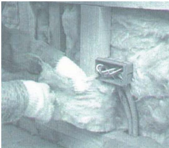
**Figura 14 - 16:** Material aislante en sectores de cajas y cañerías eléctricas.
