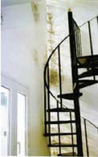
**Figura 13 - 12:** Formación de hongos en la superficie que se traduce en manchas, por efecto de la humedad por condensación.
