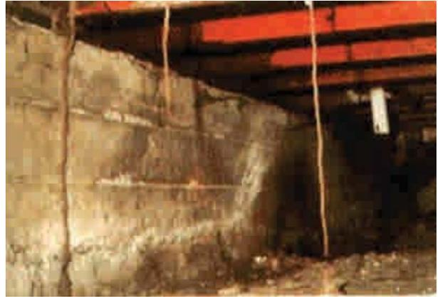
**Figura 2 - 11:** Túneles elaborados por termitas subterráneas desde el terreno, el cual contiene una humedad permanente por no estar ventilado en la zona bajo la plataforma.
