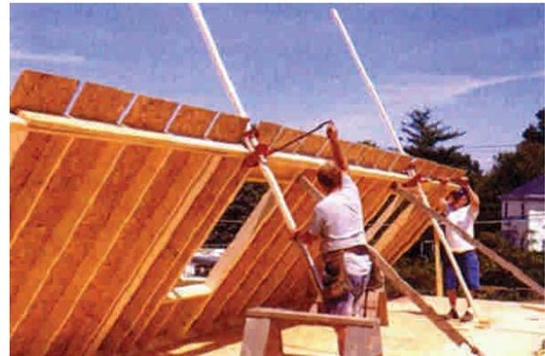
**Figura 10 - 77:** Etapa de montaje de muros prefabricados en obra directamente sobre la plataforma.
