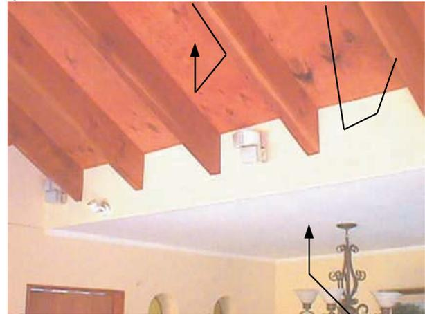
Solución de cielo con revestimiento de yeso-cartón con acabado de pintura látex
