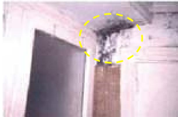
**Figura 13 - 13:** En un rincón de la habitación que colinda con un pasillo orientado hacia el lado sur de la vivienda, se observan las consecuencias de la humedad por condensación.
