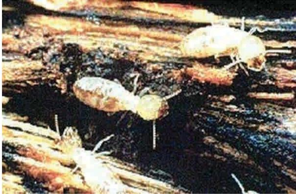
**Figura 2 - 10:** En la imagen se observan termitas subterráneas en pleno ataque a una solera de un tabique.
