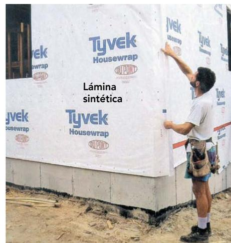
**Figura 14 - 33:** Fijación de la barrera de humedad (lámina sintética).
