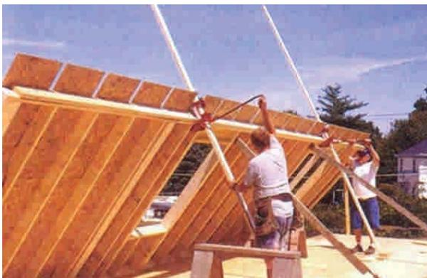
**Figura 6 - 10:** Una vez fabricados los tabiques sobre la plataforma, se procede a izarlos y ubicarlos en el lugar correspondiente.
