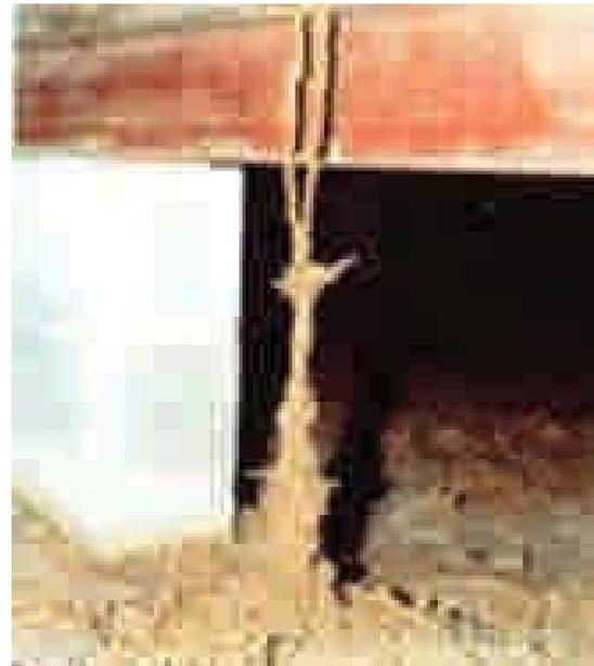
**Figura 2 - 12:** Túneles generados por las termitas subterráneas desde el terreno al friso, formando túneles con barro protector llamados tubo refugio. Conformados por fragmentos de tierra y madera digerida cementada con excrementos de las termitas obreras.
