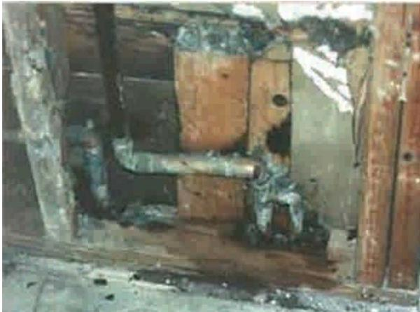
**Figura 2 – 13:** En tabique sanitario, la presencia de humedad por una pequeña filtración de la cañería de agua, crea el ambiente propicio en el interior del tabique para la presencia de termitas subterráneas. Se puede observar la destrucción del pie derecho y solera inferior.
