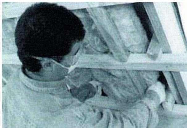
**Figura 14 - 20:** Extender el aislante en forma continua por el entramado de cielo.
