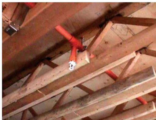
**Figura 15 - 7:** Sistema activo para el combate de incendio, consistente en dispositivo sprinkler (rociador) que requiere una instalación de red con agua a presión, independiente a la red de agua de abastecimiento del edificio. Se activa automáticamente ante un aumento desmedido de la máxima temperatura aceptada para el medio.
