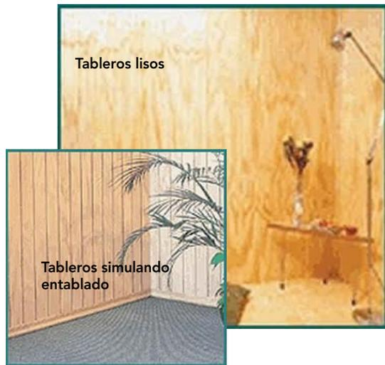
**Figura 19 - 23:** Revestimiento con tableros contrachapados.
