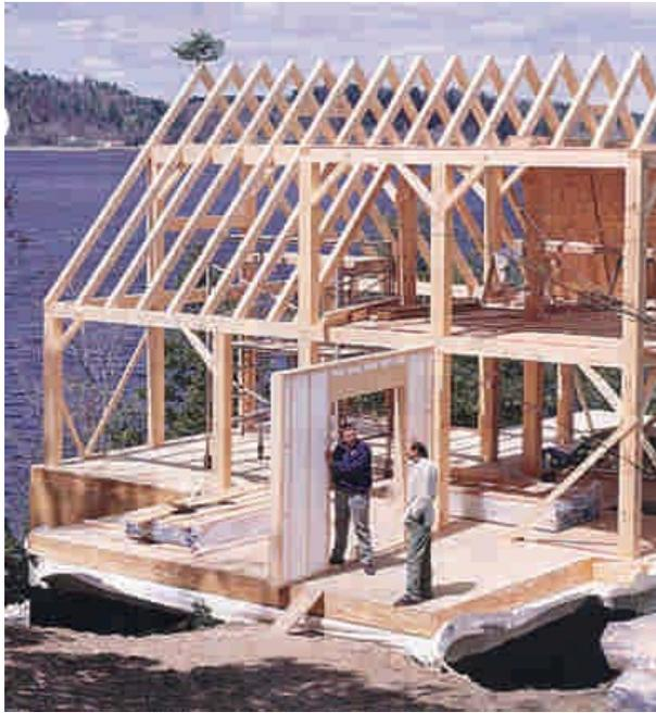
**Figura 6 - 6:** Se puede observar el conjunto de vigas horizontales e inclinadas y cómo transmiten los esfuerzos a los pilares o columnas.
