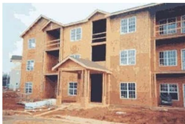
**Figura 1 - 87 :** Construcción en altura en estructura de madera y tableros de hebras orientadas, como elemento arriostrante de los entramados verticales.
