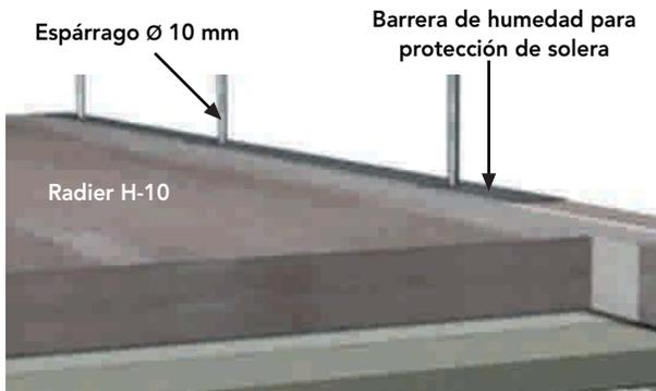
**Figura 8- 58:** Es conveniente reforzar sobre el polietileno que se instala arriba del sobrecimiento, mediante barrera de humedad bajo la solera del tabique.
