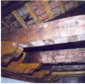
Figura 18. Apoyo de vigas en ménsulas de madera.
