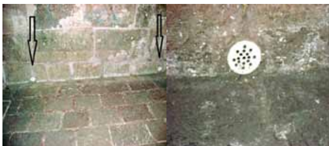
Figura 20. Sistemas de aerodren en muro.
