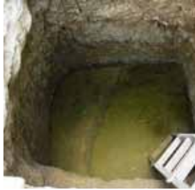
Figura 10. Agua subterránea encontrada en la iglesia de la Santísima Trinidad en Santiago de Cuba. Foto del autor.
