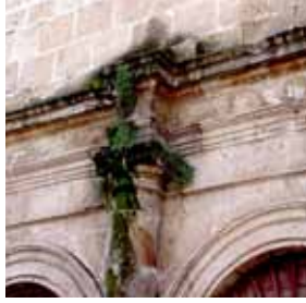
Figura 8. Enredadera en una viga de madera y enredadera en la cantería. Fotos del autor.
