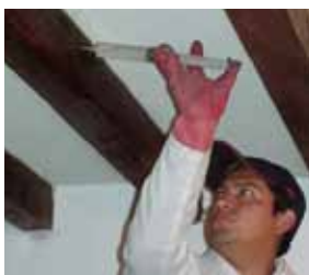
Figura 25. Aplicación de OZ por inyección. Foto del autor.
